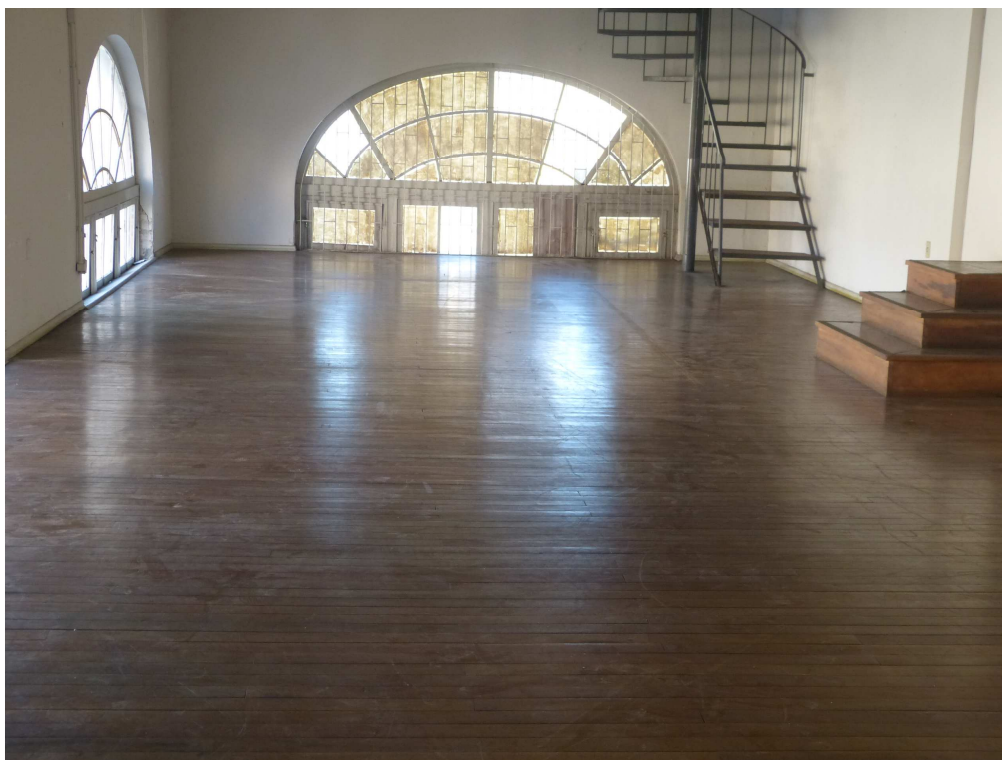
Foto 21: Sala 15 – Piso em bom estado.
