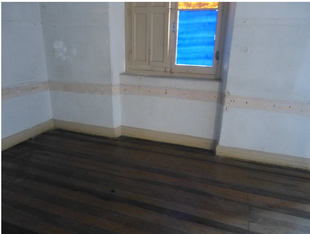
Foto 29: Sala 14 - Piso em bom estado.
