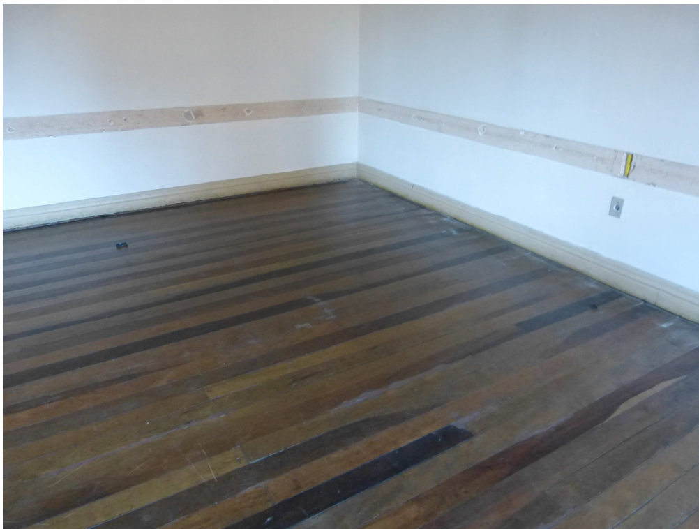
Foto 31: Sala 13 – Piso em boas condições.
