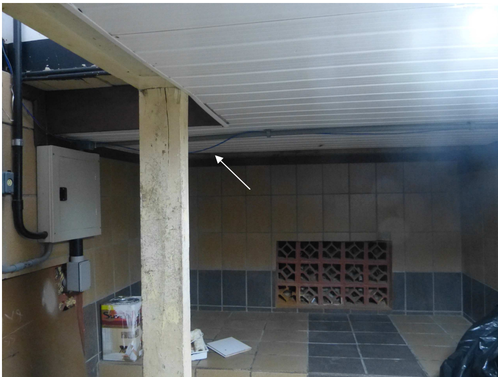
Foto 35: pilar em madeira rachado na descida da escada. Se possível, trocá-lo. Não deixar fiação elétrica solta em contato com madeira.
