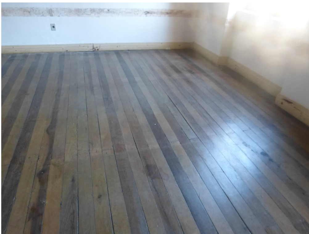
Foto 32: Sala 12 – Piso em boas condições.
