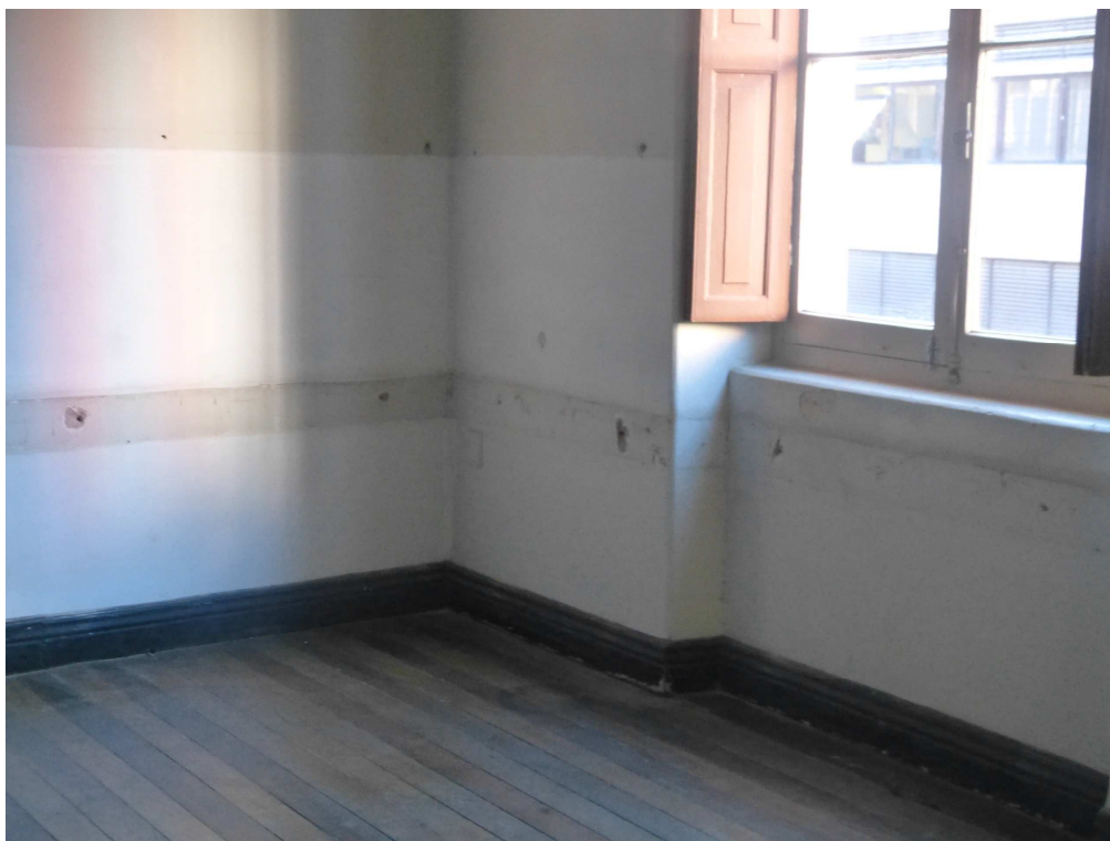
Foto 25: Sala 05 – Piso em boas condições.
