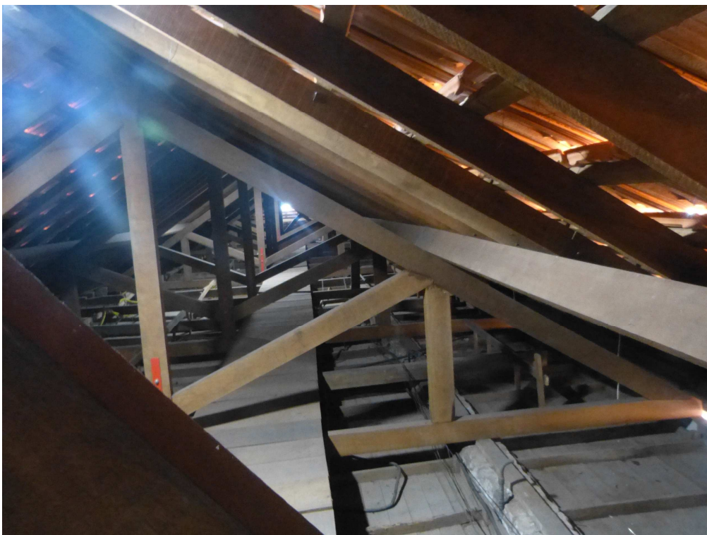
Foto 2: Estrutura do telhado no sótão.
