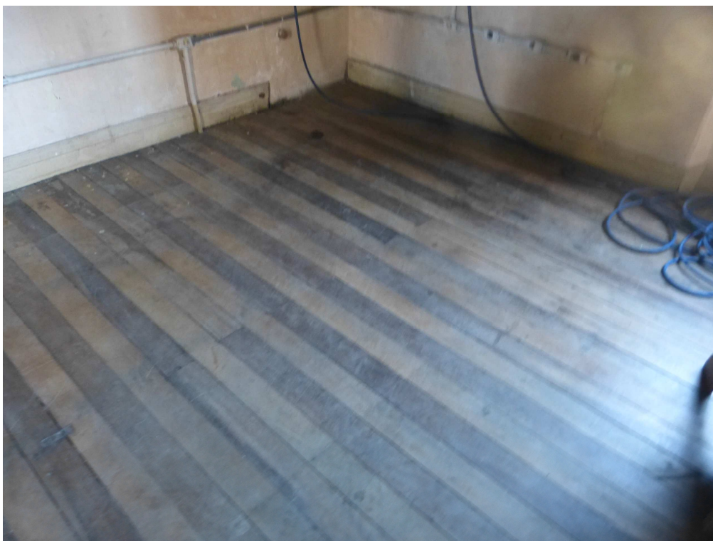
Foto 28: Sala 29 – Piso em bom estado.
