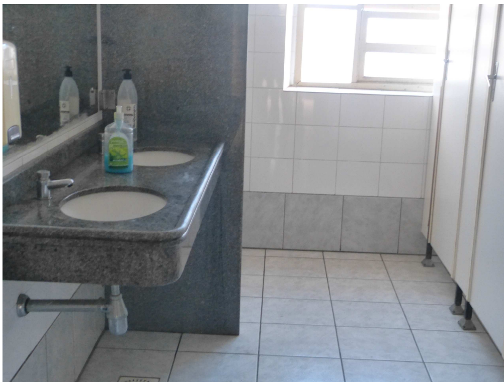
Foto 23: Sala 07 – Banheiro masculino – OK.
