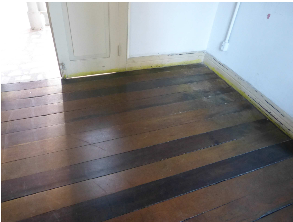
Foto 14: Sala 26 – Piso em bom estado.
