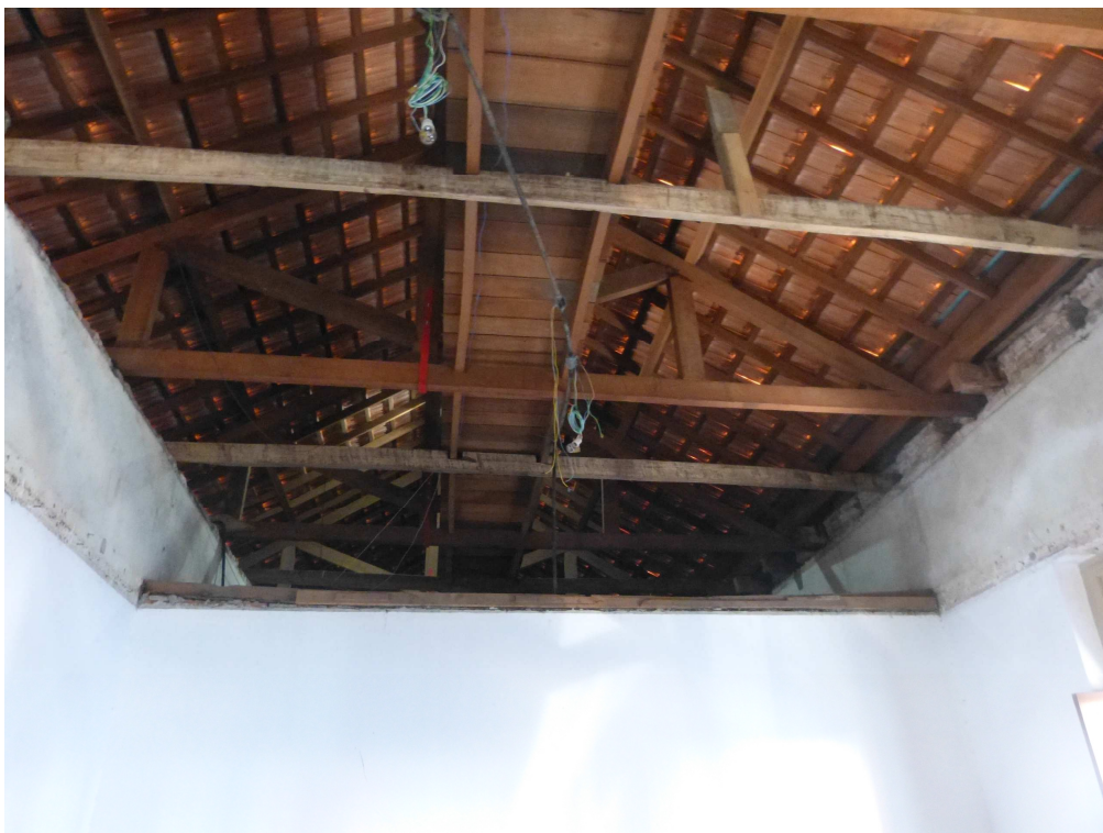
Foto 8: Sala 22 – Sem forro.
