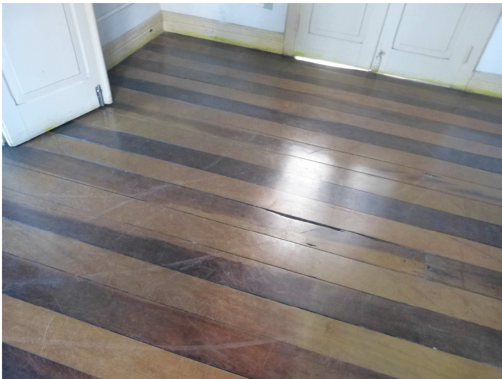
Foto 15: Sala 27 – Piso em bom estado.
