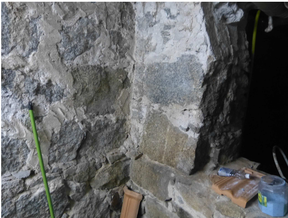
Foto 38: Paredes de pedra argamassada.
