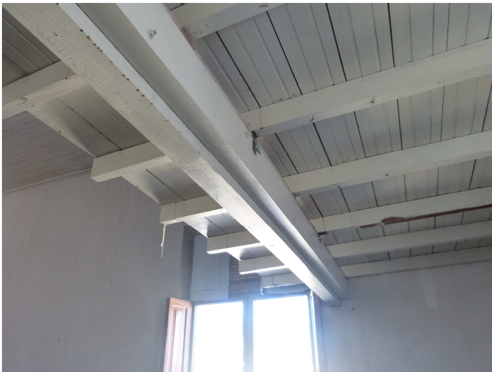
Foto 4: Mezanino – Estrutura e piso em bom estado.
