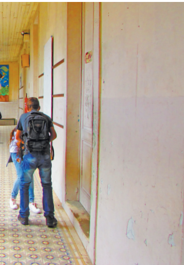
Detalhe interno: entre as características originais está o piso em ladrilho hidráulico
