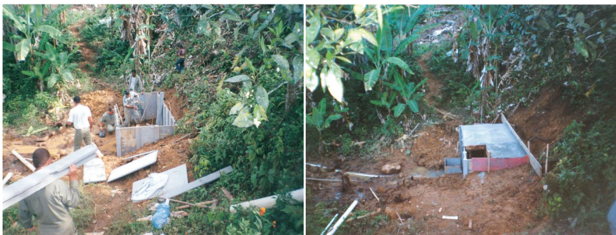
Figura 4 – Caixa de tomada de água em nascente. Fonte: FUNASA (2008).
