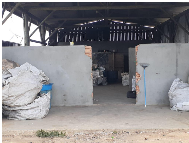
Figura 6 – Centro de Triagem (vista lateral)
