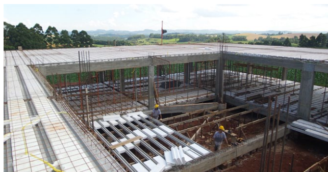
De cima para baixo: Obra em Pinhalzinho está em andamento; prédio de Laguna, a maior obra pública da cidade; prédio da Ambiental (excelente custo x benefício foi adotado em outras unidades); lançamento da pedra fundamental em Ibirama.
