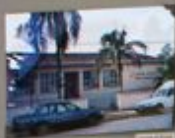
Exterior do Colégio
