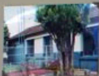
Exterior do Colégio
