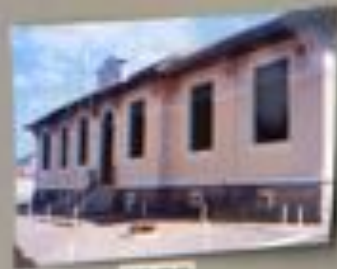
Exterior de la escuela
